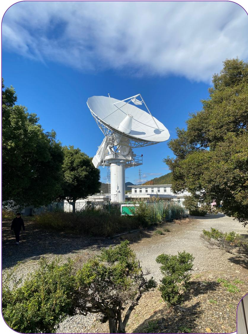
岐阜大学 11-m 電波望遠鏡は、大学キャンパス内に設置された中口径のカセグレンアンテナです（1996年製）。通信総合研究所（現在のNICT）による首都圏地殻変動観測計画のために製作され、運用終了後の2002年に岐阜大学へ譲渡されました。移設当時は2/8GHzでの運用でしたが、2006年の22GHz帯受信機搭載後は、水メーザーやアンモニア輝線による観測を進めています。2014年には、銀河中心ブラックホールのモニター観測などで成果をあげました。
