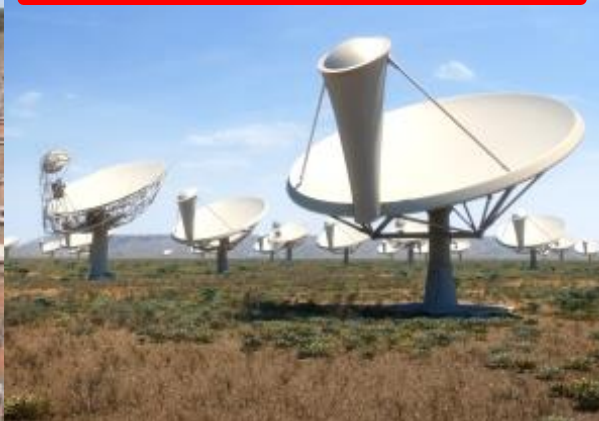
SKA2-DISH 南ア 15m SKA鏡 2500台 最大基線長3500km PAFか広帯域フィード
